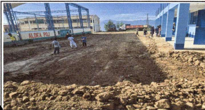
Foto1: Fundición de plancha de concreto en patio frontal, 21.3 X 3.15 m² lado Oriente
